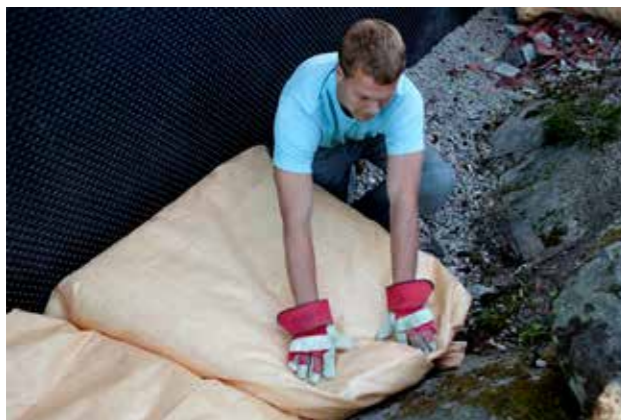
Tilbakefylling med lette og drenerende masser. Løs Leca og Jackopor lettfyll.
