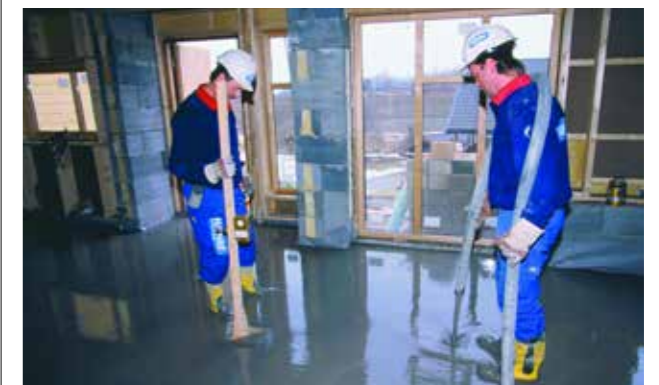
Gulv på grunn med flytsparkel.
