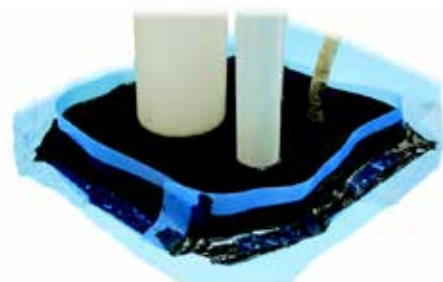
Eksempel på rørgjennomføring med Rad(ON) Radonsperre, Topp-tape og Skjøtetape, fylt med Rad(ON) 5 Bitumen i 30 mm dybde.
