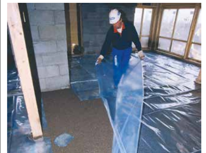
Plastfolie som fuktsperre.
