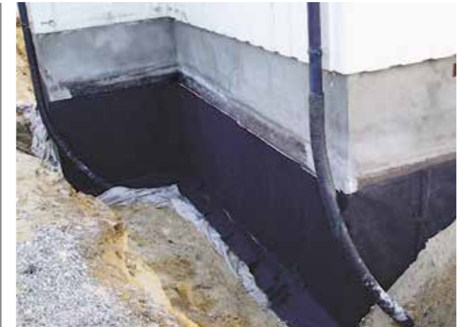
Drensplade av EPS med fiberduk. Drenerende og kapillærbrytende sjikt utenpå vegg.
