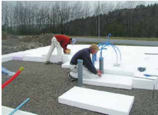
Utlegging av gulvisolasjon.
