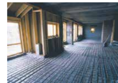
Armeringsnett over fiberduk og plastfolie.
